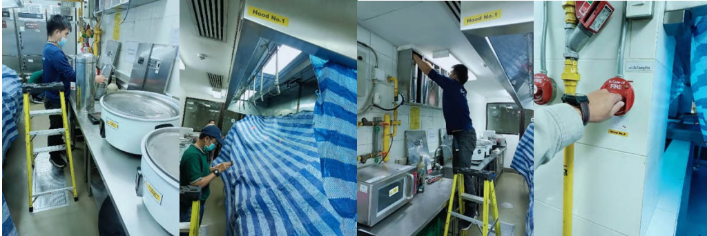
(ภาพการตรวจสอบระบบดับเพลิงภายในห้องครัว) (Ansul system)
